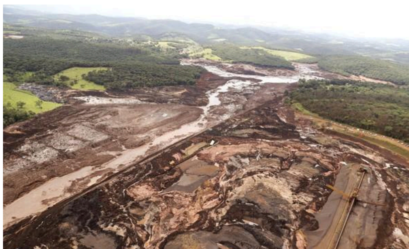
Figura 1 - Destruição causada pelo rompimento da barragem em Brumadinho. Foto: André Penner.
