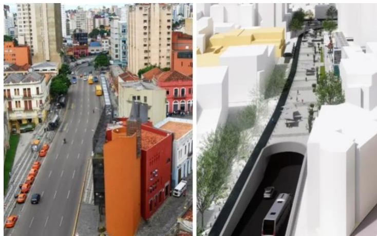
FIGURA 4 – TRINCHEIRA NA TRAVESSA NESTOR DE CASTRO
